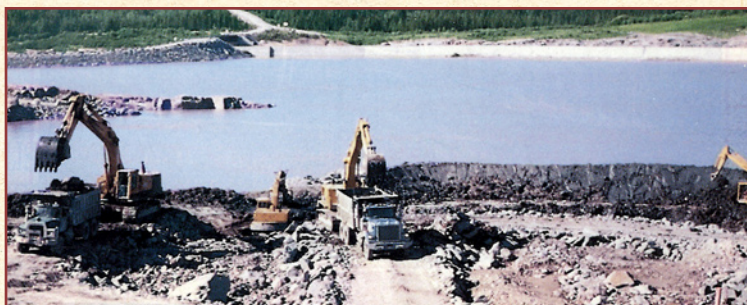
Construction de barrages à la Baie-James (1988).
